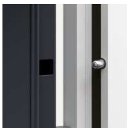
bezpečnostné trne proti vysadeniu – KWARC Typ III
