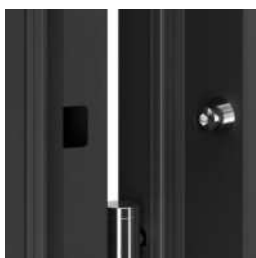
bezpečnostný trň proti vysadeniu
